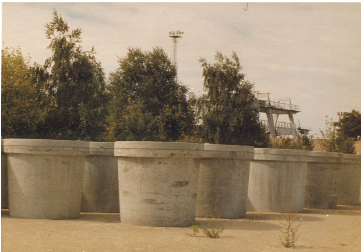
4. ábra: A MÁV veszélyes hulladékainak tárolására készített vasbeton zárványelemek
