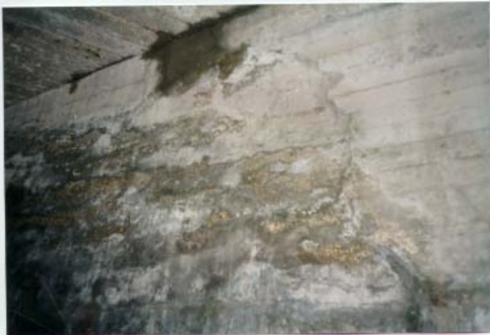
7. sz. kép Vízbefolyás a felső szerkezet és a szerkezeti gerenda csatlakozásánál
