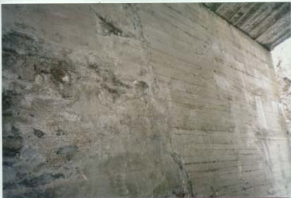
7. sz. kép Vízbefolyás a felső szerkezet és a szerkezeti gerenda csatlakozásánál
