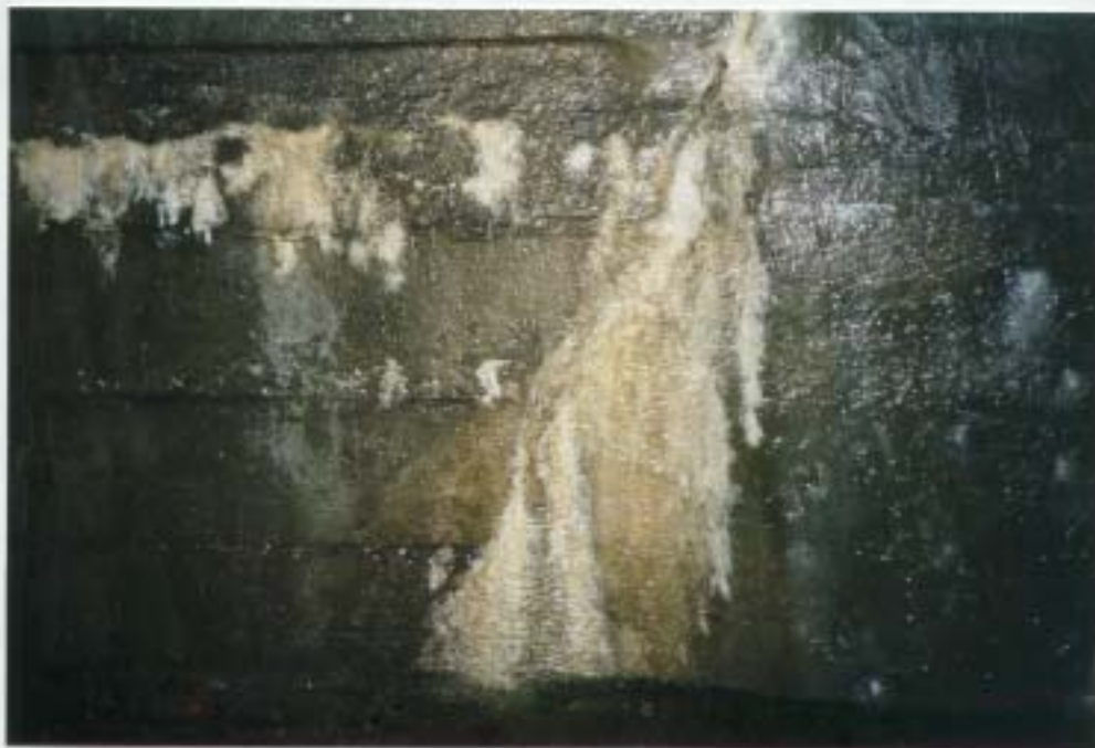
11. sz. kép Cseppkőképződés a munkahézag mentén
