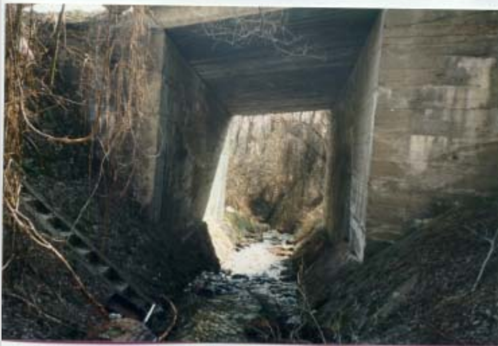
1. sz. kép. A befolyási oldal falai
