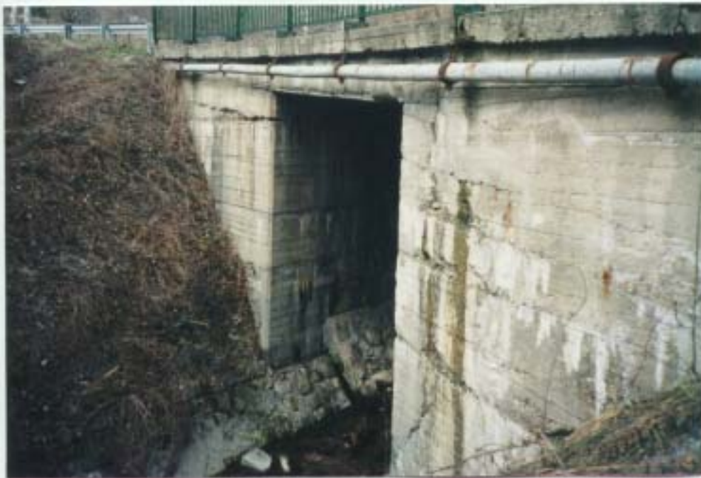
4. sz. kép Kifolyási oldali falak az erősen kifagyott munkahézagokkal
