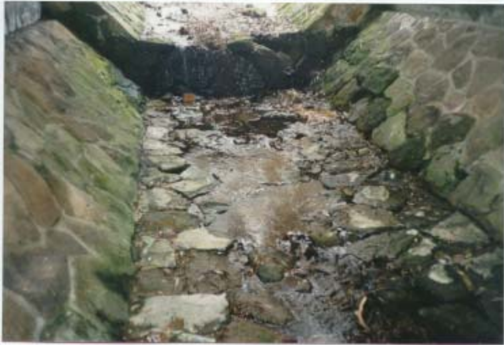
17. sz. kép Mederburkolat a híd alatt
