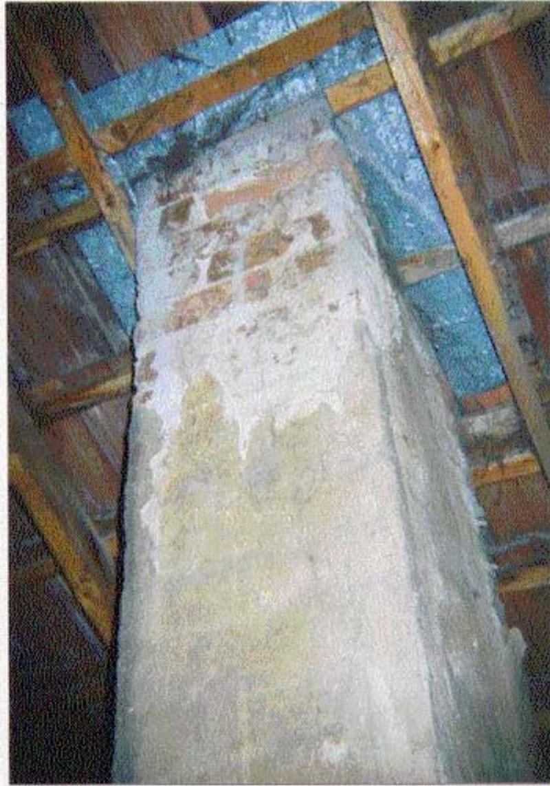
A megsérült béléscsöves kémény vakolata a padlástérben
