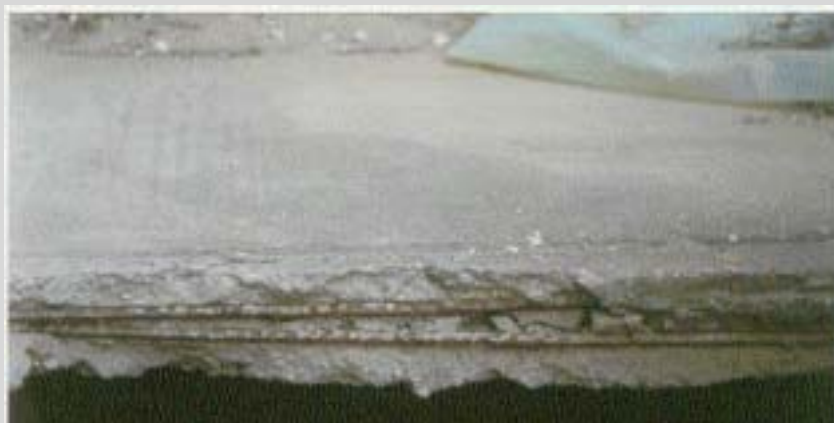
A pincelejáró feletti monolit vasbeton lemez
